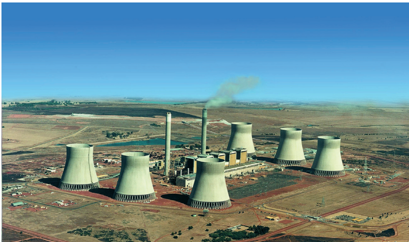
6 x 690 МВт Угольная электростанция Kendal, Южная Африка - 1992
