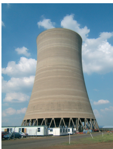
200 МВт Угольная электростанция Grootvlei, Южная Африка - 1978
