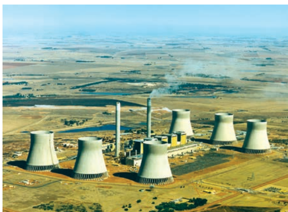
Самая большая в мире система сухого охлаждения с естественной тягой. Электростанция «Кендал» 6 x 690 МВт, ЮАР, построенная SPX
